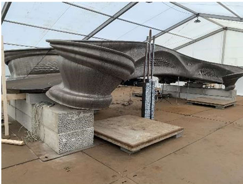
Figuur 5 - Robotisatie en automated manufacturing als onderdeel van de digitalisering op de bouwplaats (voorbeeld Fieldlab Sensorized 3D Printed Bridge Campus UTwente)
